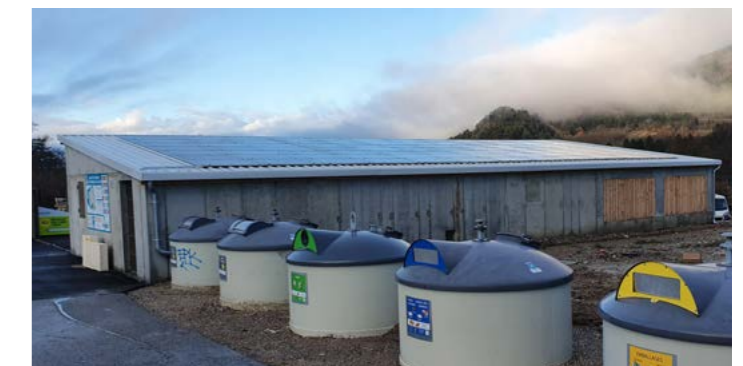
▲ Toiture équipée sur l'aire de tri de Luc-en-Diois
